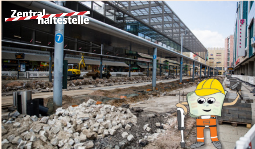
Stand 20. April 2017: Die Bahnsteige in der Rathausstraße wurden vollständig abgebrochen. Am Bahnsteig 8 entsteht das neue Gleis und am Bahnsteig 6 eine neue Busspur.
