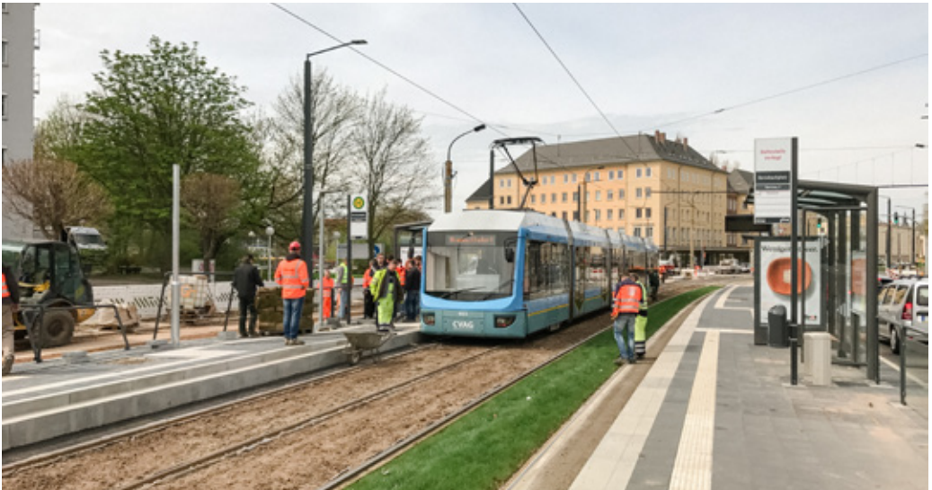
Stand 12. April 2017: Technische Abnahme und Probefahrt des Streckenabschnittes Reitbahnviertel
