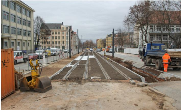
**Ende des zweiten Bauabschnittes in Höhe Dittesstraße. Hier schließt sich ab März der dritte Bauabschnitt an. Im Gleisbereich wurde das Pflanzgranulat für den Rasen eingelassen.**
