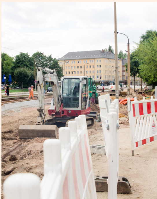
Oben: Im Bereich des Nettomarktes in Höhe der Straßenbahnhaltestelle Bernsbachplatz ist der Straßen- und Gehwegaufbau zurückgebaut.
