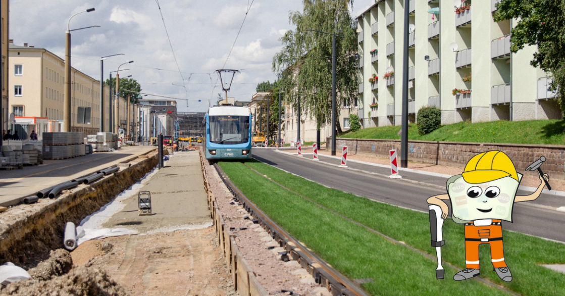
Der Rollrasen ist in das neu gebaute, stadtwärtige Gleis verlegt. Die stadtwärtige Fahrbahn ist bis auf die Asphaltdeckschicht fertiggestellt. Stand: 11.08.2016
